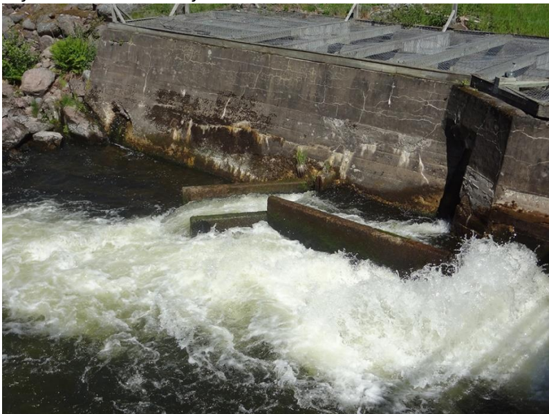
Figur 62. Nedre delen av bassängtrappan i Laxberg. Smolten ska simma/hoppa in i trappan mot en relativt hög vattenhastighet. Övrig tappning från dammen släpps intill fiskvägen för att öka anlockningen.
