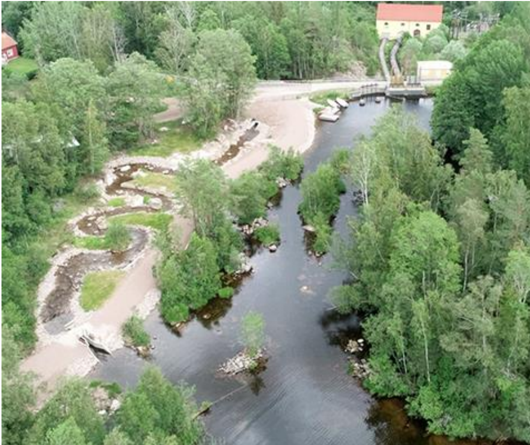
Figur 61. Vid dammen i Forsnäs (Bulsjöån), uppströms sjön Sommen i Östergötland, har Tranås energi låtit Jönköpings Fiskeribiologi AB etablera ett inlöp (2,2% lutning) för både upp- och nedströms fiskpassage. Framför kraftverkets intag sitter ett intagsgaller med 15 mm spaltbredd och 35 graders lutning mot horisontalplanet. Fisken avleds ned till omlöpet. Flödet i omlöpet är 600 l/s, motsvarande normal lågvattenföring (MLQ). Foto: Peter Lindvall, Jönköpings Fiskeribiologi AB.
